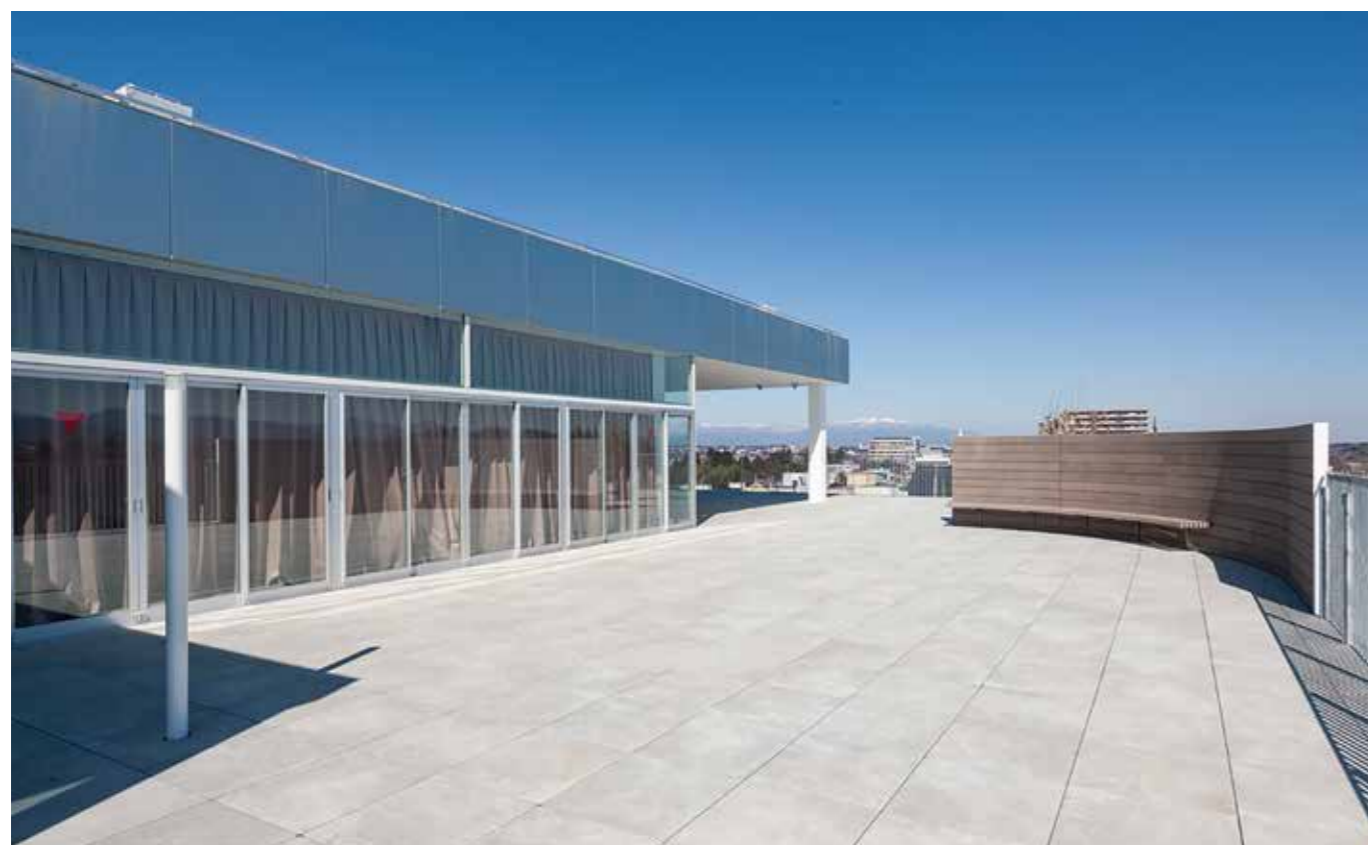
福島県須賀川市民交流センター「tette」 LM2661A(ライトベージュ)、LM2665A(ライトグレー)
