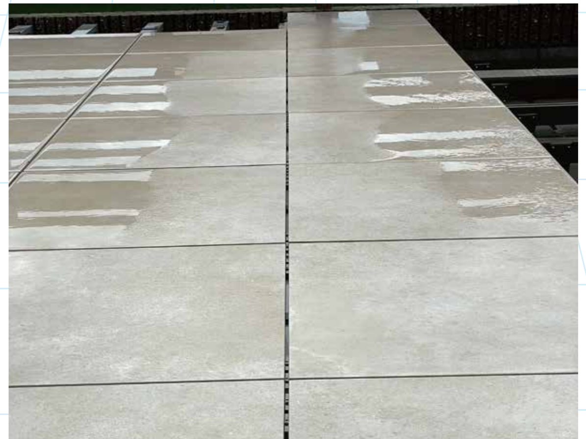
対応策として、600×600×20 タイルに1/200傾斜をつけることにより改善しました。(3時間経過)
