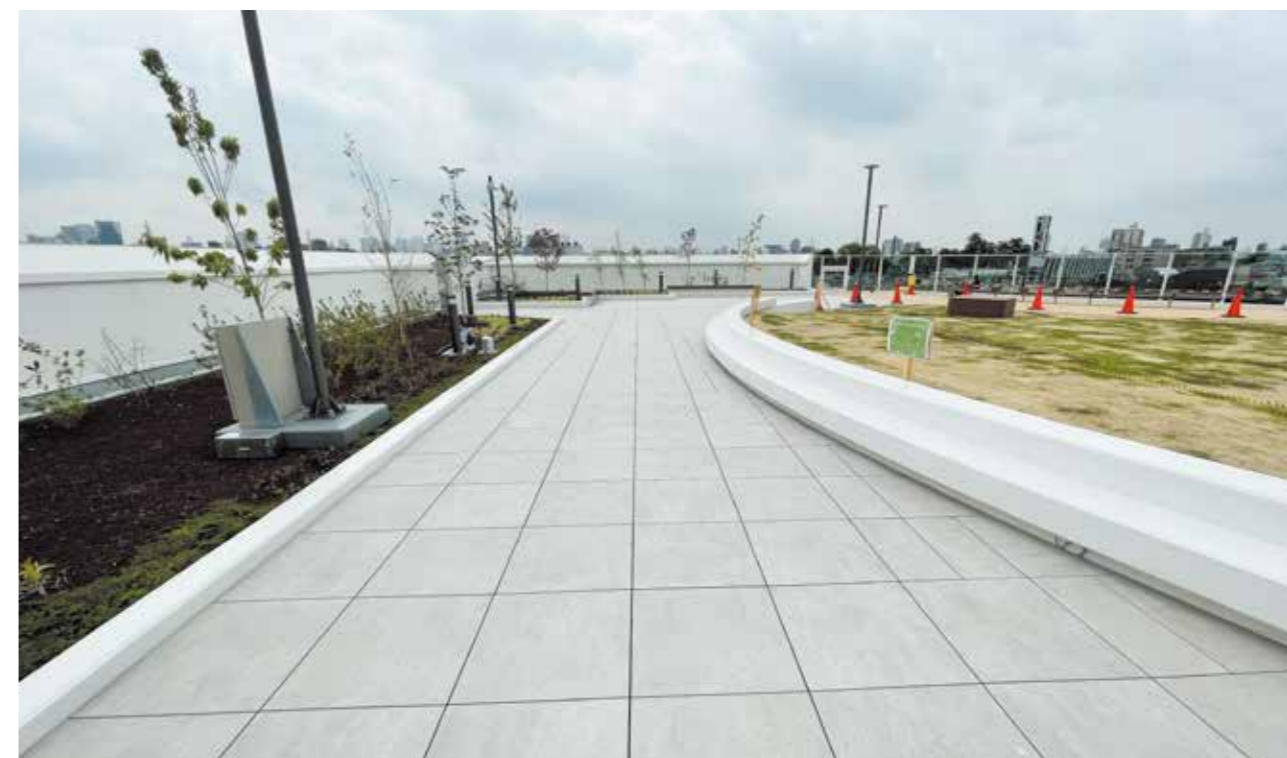
杉並区阿佐ヶ谷地域区民センター「屋上庭園」
